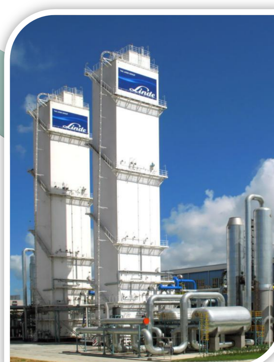
Luftzerlegungsanlage Quelle: www.linde.com
